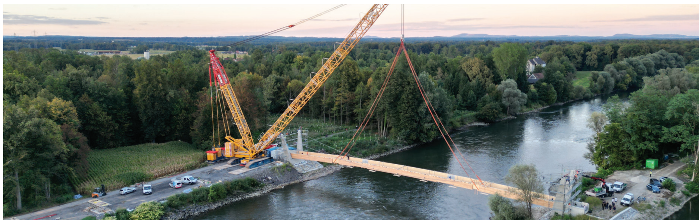
Slika 16. Popuščanje žerjava, montaža je končana
