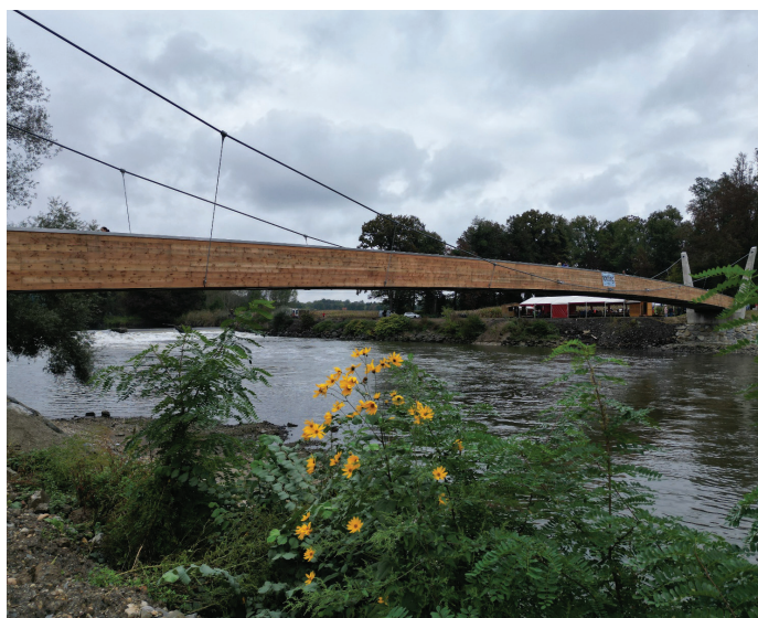
Slika 1. Most Ceršak na dan otvoritve (27. september 2025)
