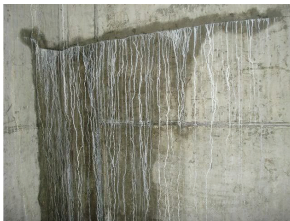
Slika 4. Neuspeli poskusi tesnjenja razpok v vkopanih obodnih stenah in vtekanje podzemnih vod v notranjost garaž
