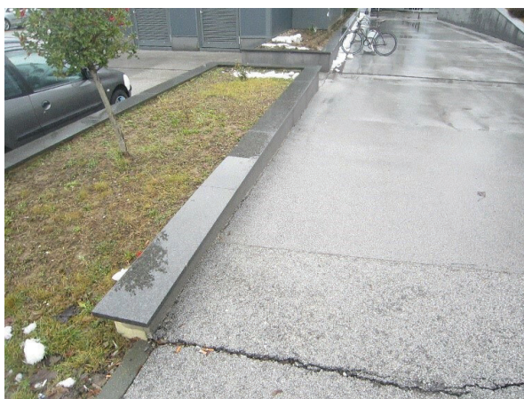
Slika 3. Poškodbe bližnjih vozni površin, ki se kažejo v obliki razpok in diferenčnih dvigov
