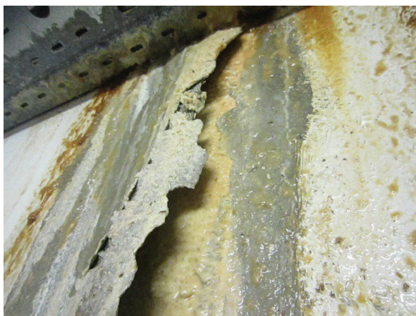
Slika 4. Neuspeli poskusi tesnjenja razpok v vkopanih obodnih stenah in vtekanje podzemnih vod v notranjost garaž
