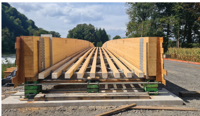
Slika 12. Prekladna konstrukcija je pripravljena na dvig in montažo
