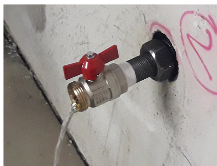
Slika 10. Tlorisna razporeditev izpustnih mest za odvajanje ujete vode, injekcijski nastavki z nameščenim in odprtim ventilom ter iztekanje ujete vode po prevrtanju notranje stene "dvojne kadi"
