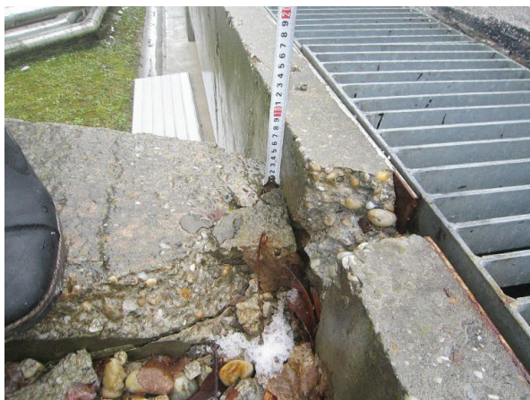
Slika 2. Dvigi obravnavane podzemne garaže in poškodbe, ki so se pojavile na stikih z okoliškimi objekti
