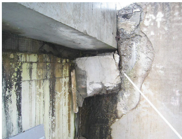
Slika 2. Dvigi obravnavane podzemne garaže in poškodbe, ki so se pojavile na stikih z okoliškimi objekti
