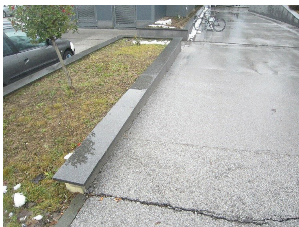
Slika 3. Poškodbe bližnjih voznih površin, ki se kažejo v obliki razpok in diferenčnih dvigov
