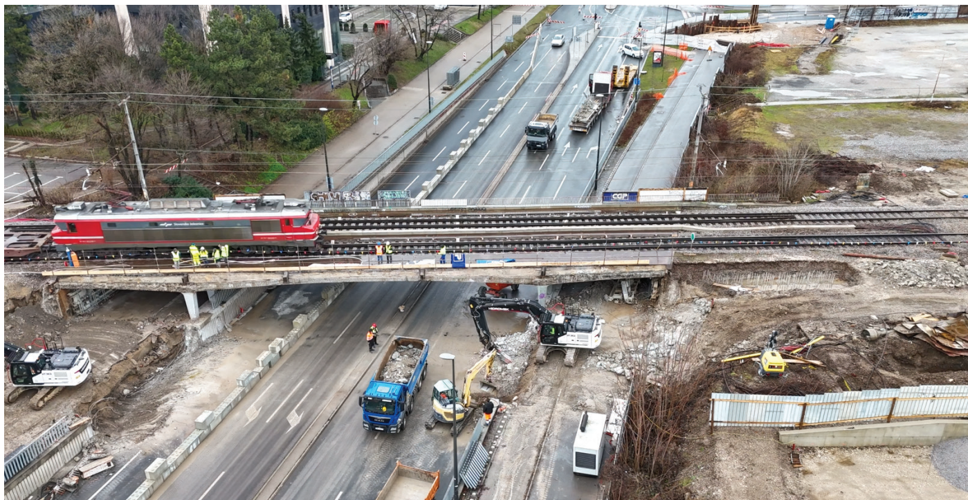
Slika 4. Južni del podvoza je v celoti odstranjen. 7. januar 2024.
