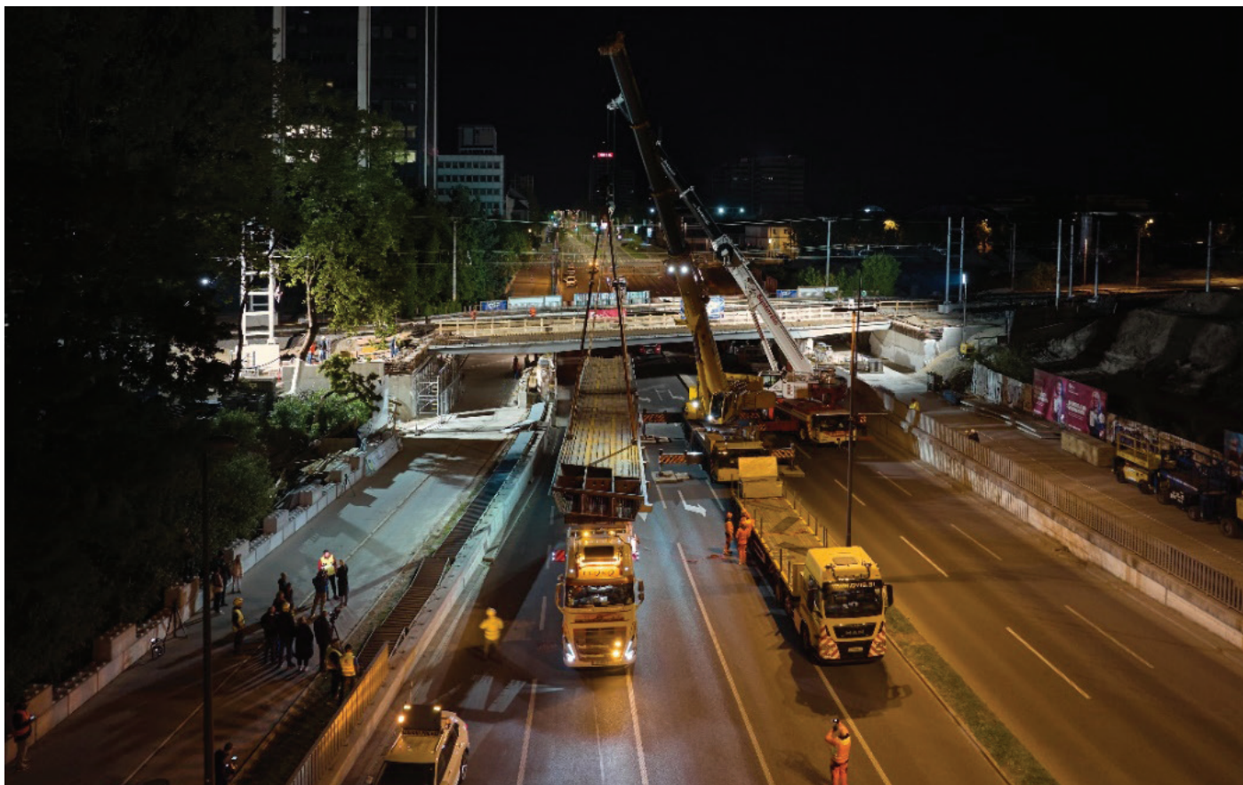
Slika 7. Priprava na dvig prvega škatlastega jeklenega nosilca, južna stran podvoza. 20. april 2024.
