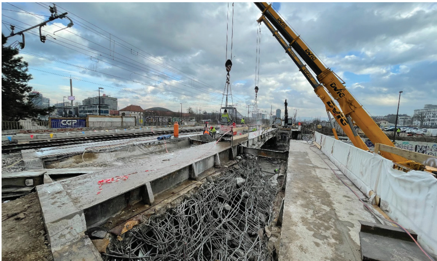
Slika 2. Rušitev južne polovice obstoječega podvoza. Odstranjevanje prednapete armiranobetonske plošče v območju negativnih momentov, ki je del sovprežnega prereza. 5. januar 2024.
