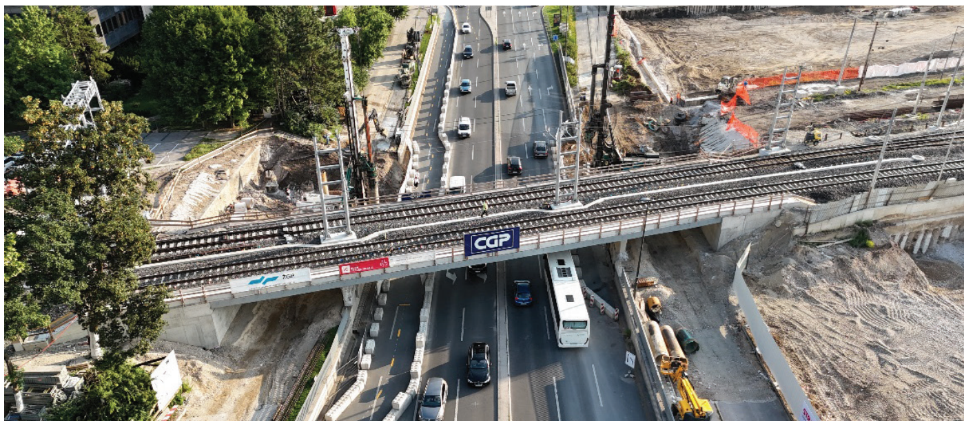
Slika 9. Dokončan južni del podvoza. Izvajajo se piloti za severni del. 25. julij 2024.
