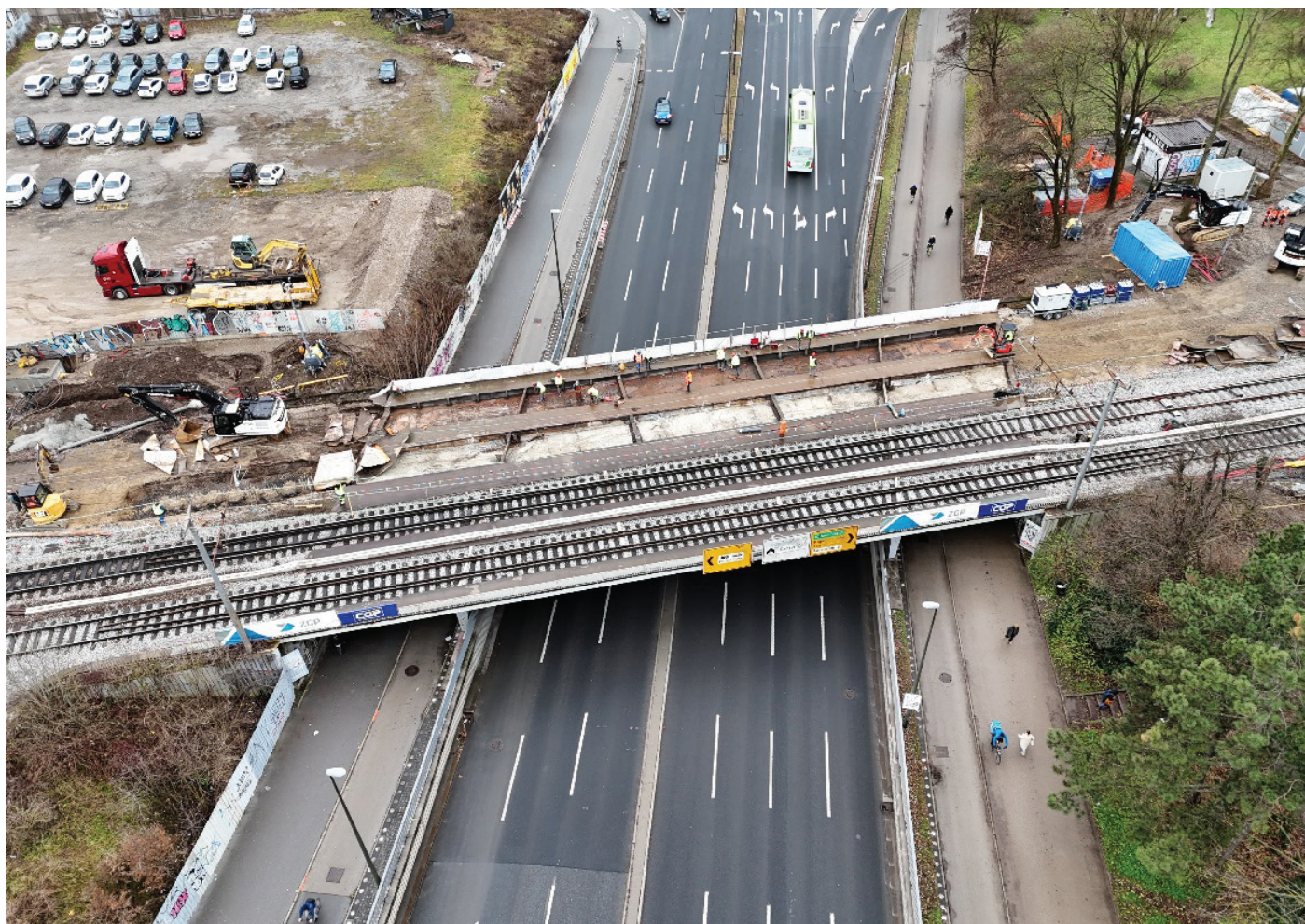
Slika 1. Začetek rušitve južne polovice obstoječega podvoza. Odstranjeni so dva tira in tirna greda. 3. januar 2024.
