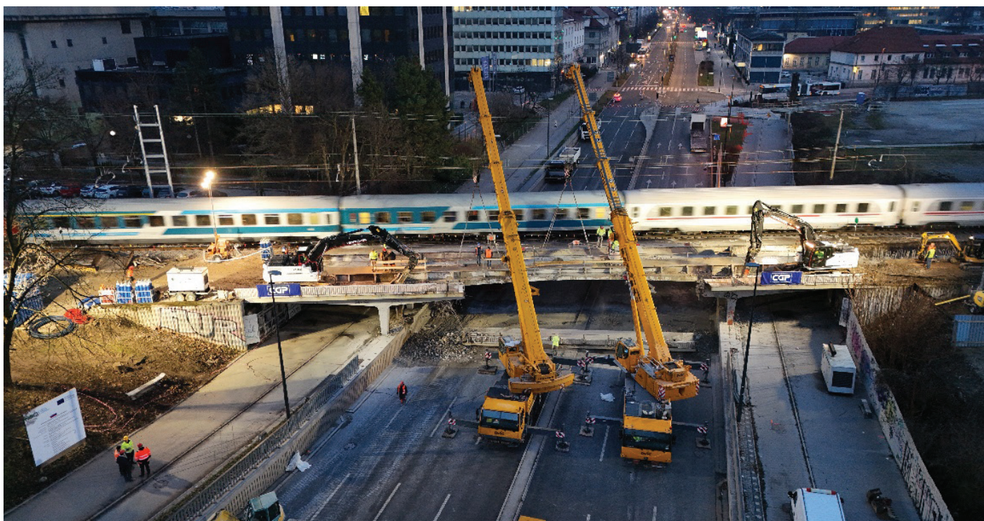
Slika 3. Rušitev južne polovice obstoječega podvoza. Spust prvega jeklenega nosilca. 5. januar 2024.
