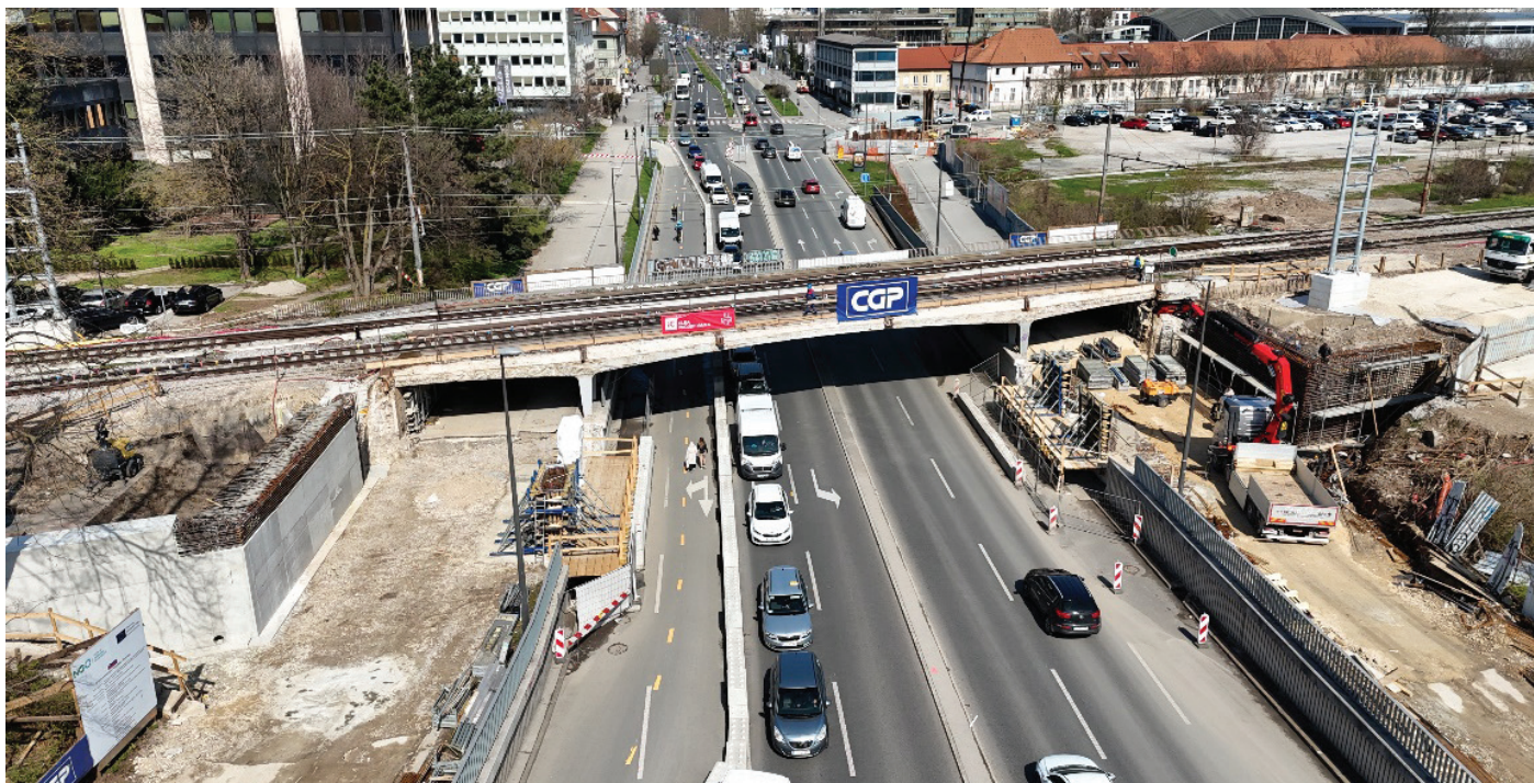
Slika 6. Gradnja krajnih opornikov in vmesnih podpor, južna stran podvoza. 23. marec 2024.
