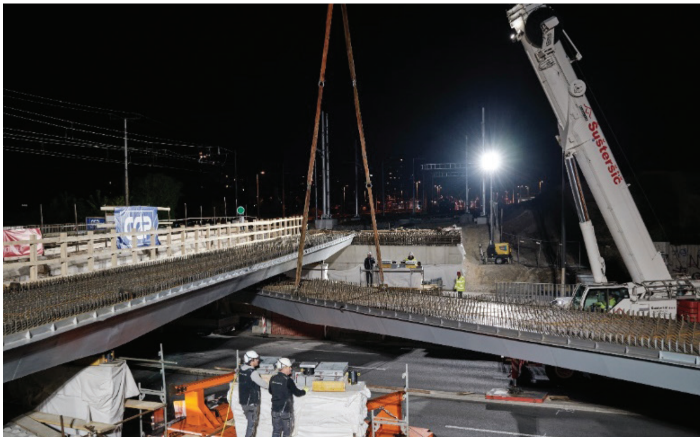
Slika 8. Montaža prvih dveh škatlastih jeklenih nosilcev, južna stran podvoza. 20. april 2024.
