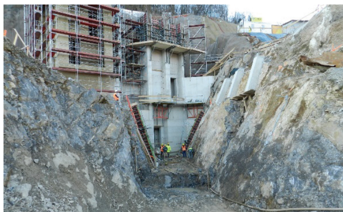
Slika 18. Gradnja dovodnega jarka.
