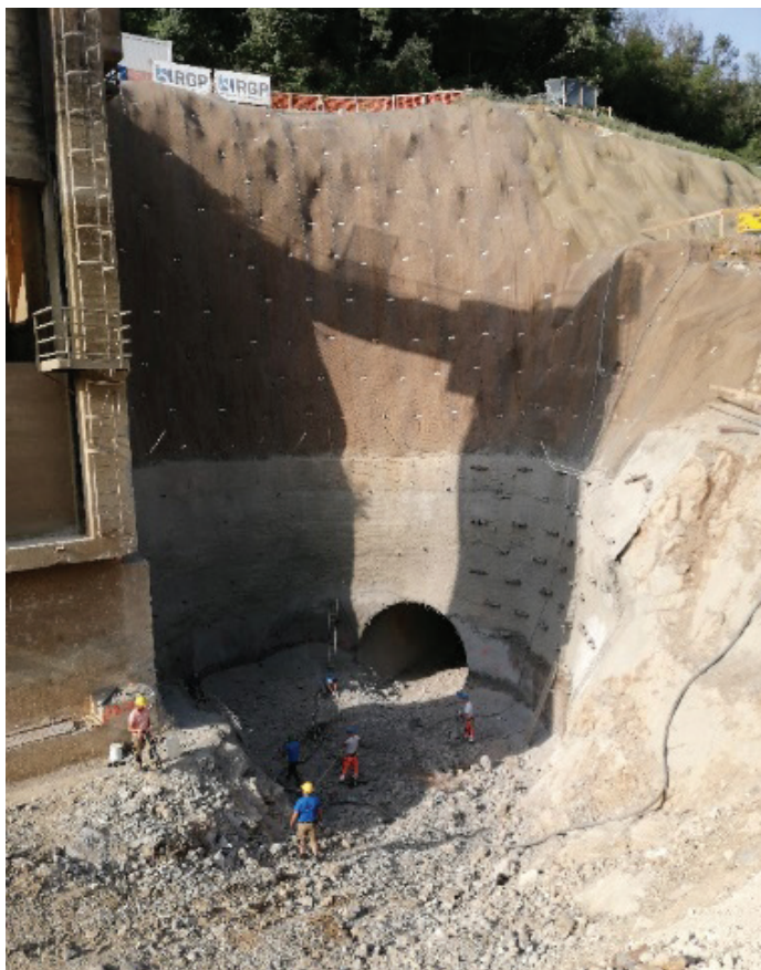
Slika 7. Gradbena jama – spoj s predorom.
