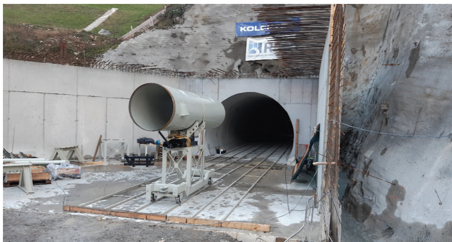
Slika 26. Transport cevi v predor za montažo.
