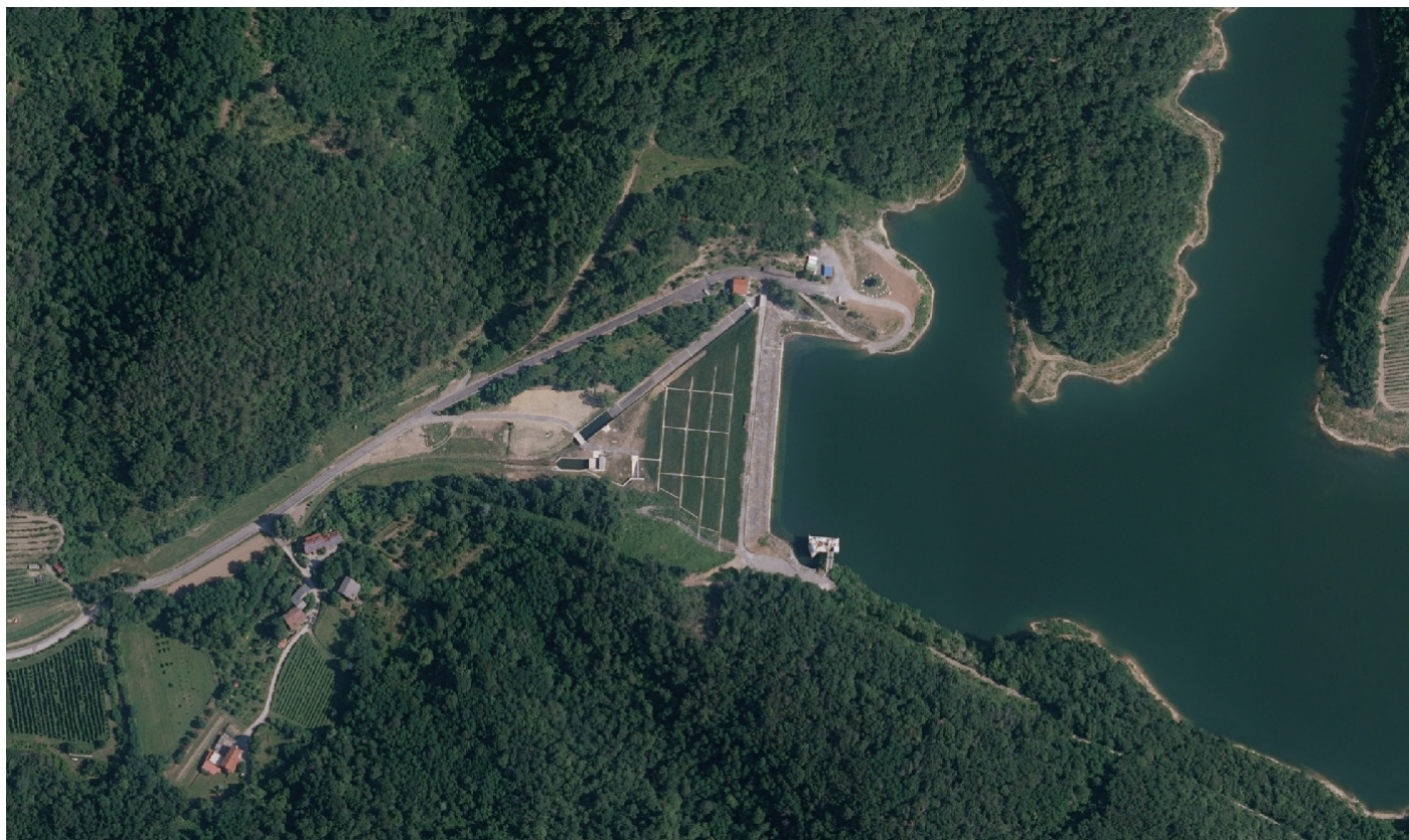
Slika 1. Pregrada Vogršček po končani sanaciji (povzeto po GURS).
