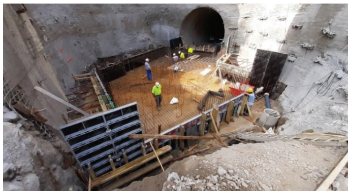
Slika 8. Temeljna plošča novega odzemnega objekta.
