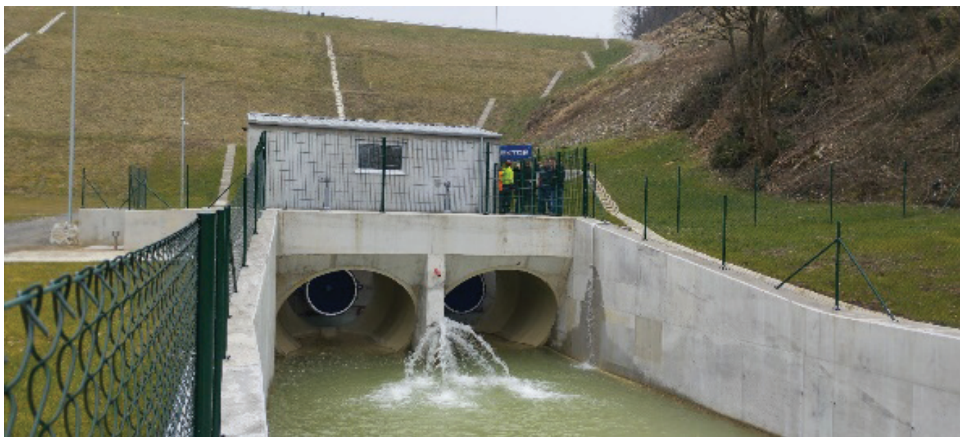
Slika 28. Iztočni objekt z deflektorji.
