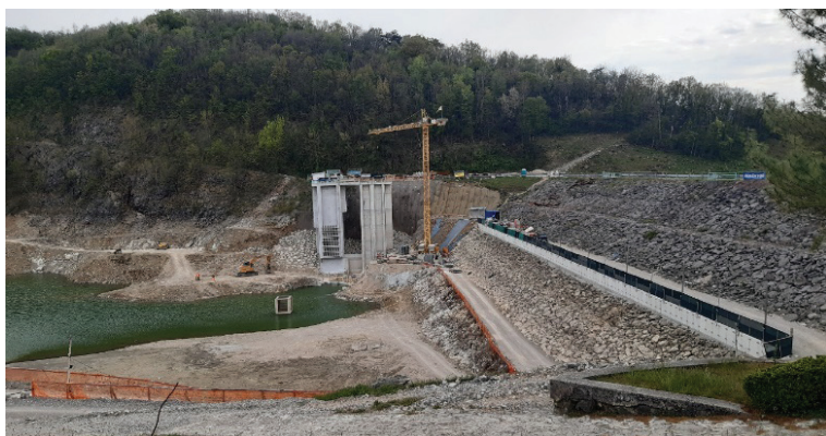
Slika 15. Novi odzemni objekt – faza del.
