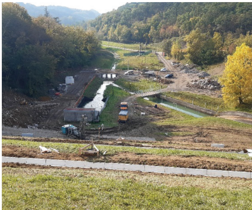
Slika 2. Dostopne poti in portal kot priprava za začetek gradnje predora.
