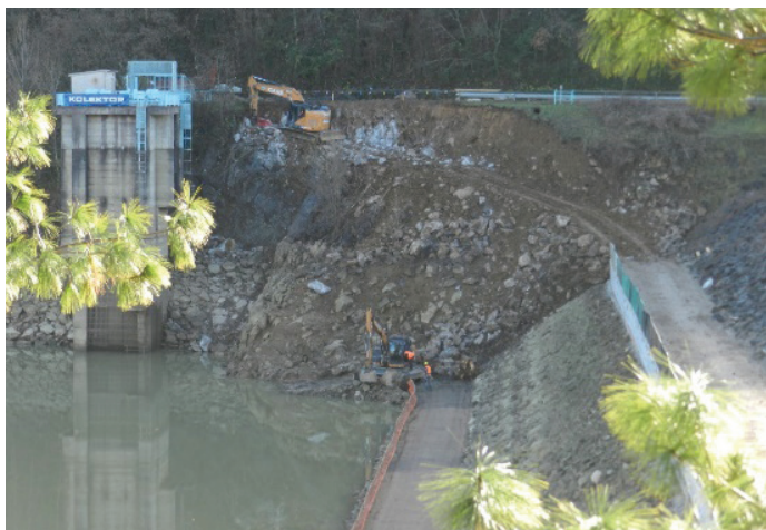
Slika 5. Gradbena jama za odzemni objekt – začetno stanje.
