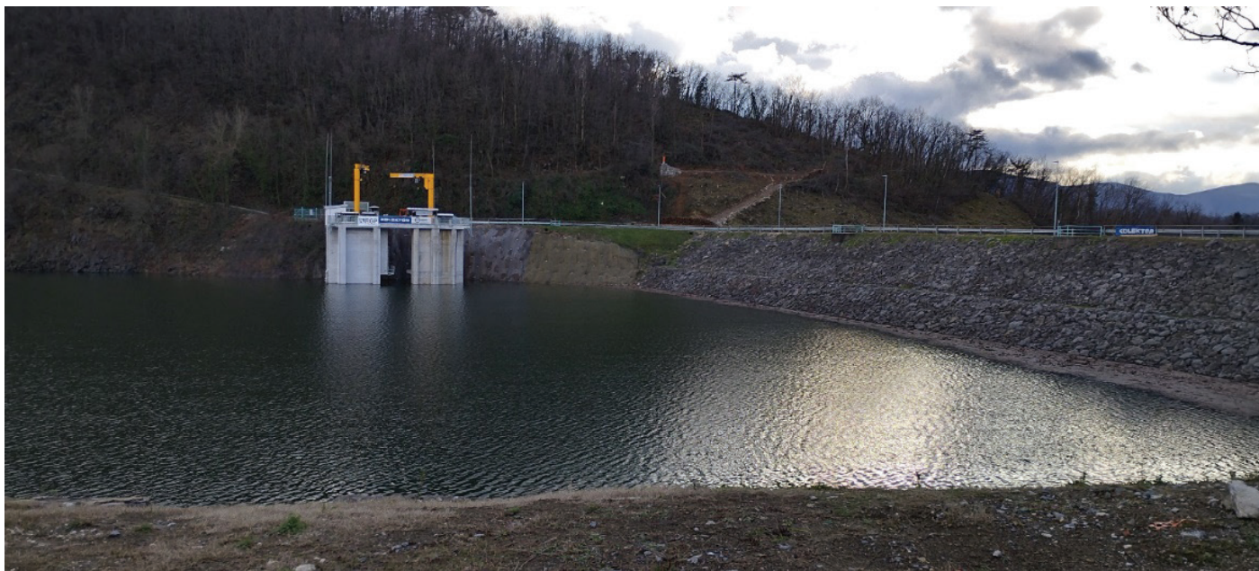
Slika 29. Vodna stran po zaključku del.
