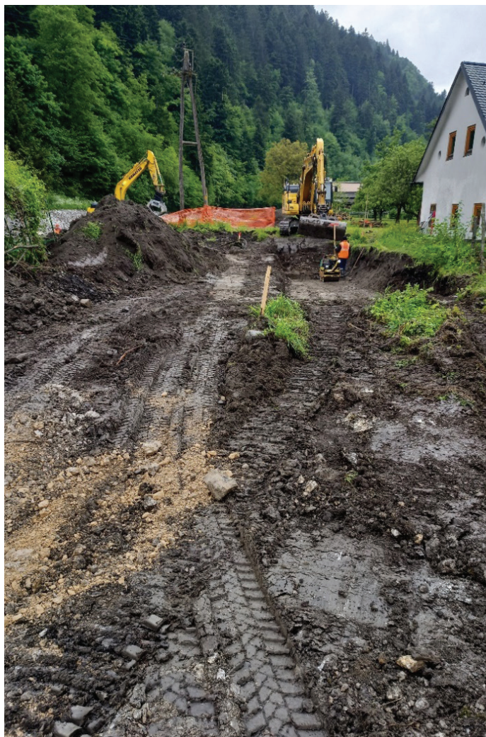
Slika 5. Pripravljalna dela za prestavitev ceste.
