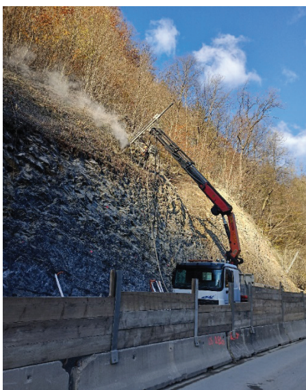
Slika 9. Vrtanje in vgradnja pasivnih sider.
