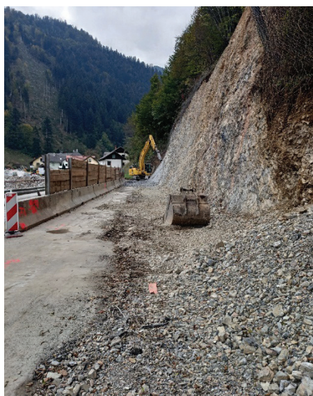
Slika 8. Vkop v strmo skalno brežino.
