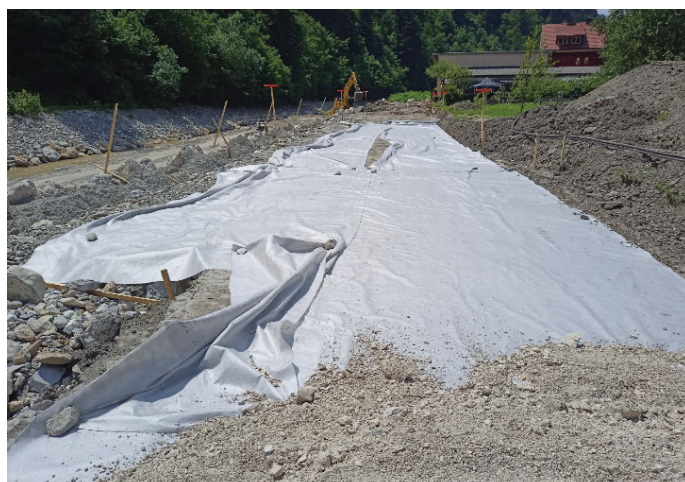
Slika 7. Izvedba ustroja vozišča na položeni geosintetik.
