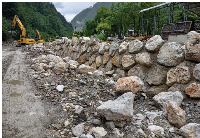
Slika 6. Izvedba podpornega zidu ceste – kamen v betonu.
