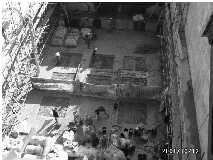
Slika 2. Vgrajevanje poskusnih polj v podslapju.
