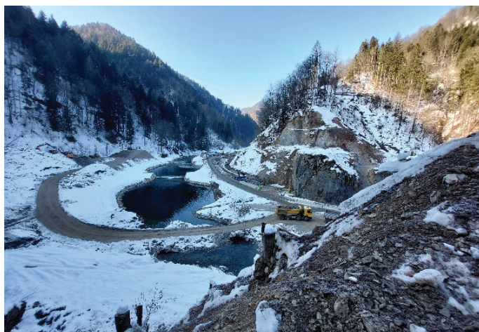
Slika 6. Gradbišče pozimi, izvedeni sta dve lovilni jami od predvidenih treh, namenjeni zadrževanju proda. V času zadnjih poplav sta že odigrali svojo vlogo (Foto: Karolina Korenčan).
