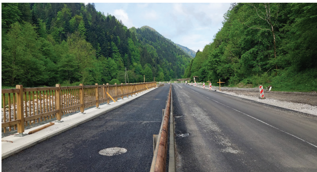
Slika 22. Asfaltiranje ceste (Foto: Karolina Korenčan).
