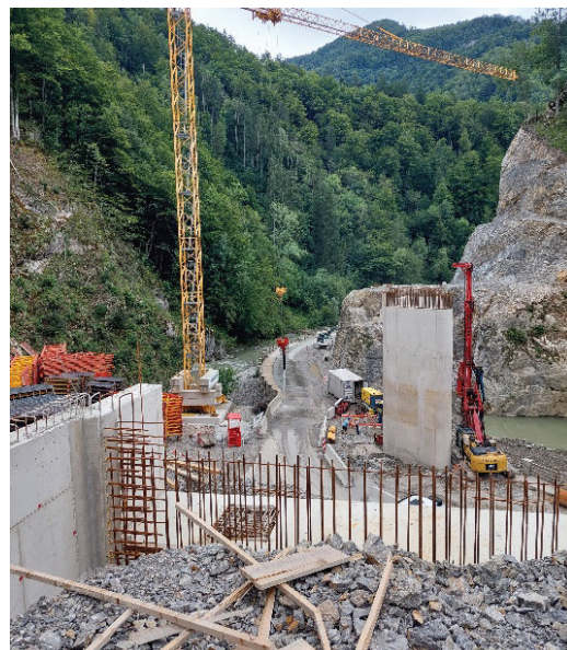
Slika 11. Pogled s krajnega opornika na gradnjo vmesnega opornika mostu (Foto: Karolina Korenčan).
