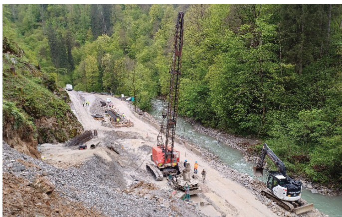
Slika 7. Izdelava pilotov za temeljenje gabionskega zidu (Foto: Amir Pjanić).
