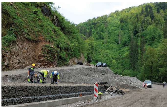
Slika 8. Gradnja gabionskega zidu (Foto: Karolina Korenčan).
