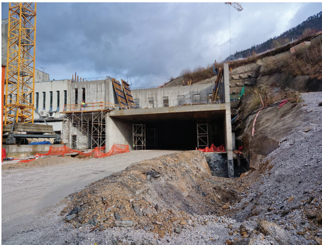
Slika 11. Portalna stavba v izgradnji, sledi izvedba galerije.
