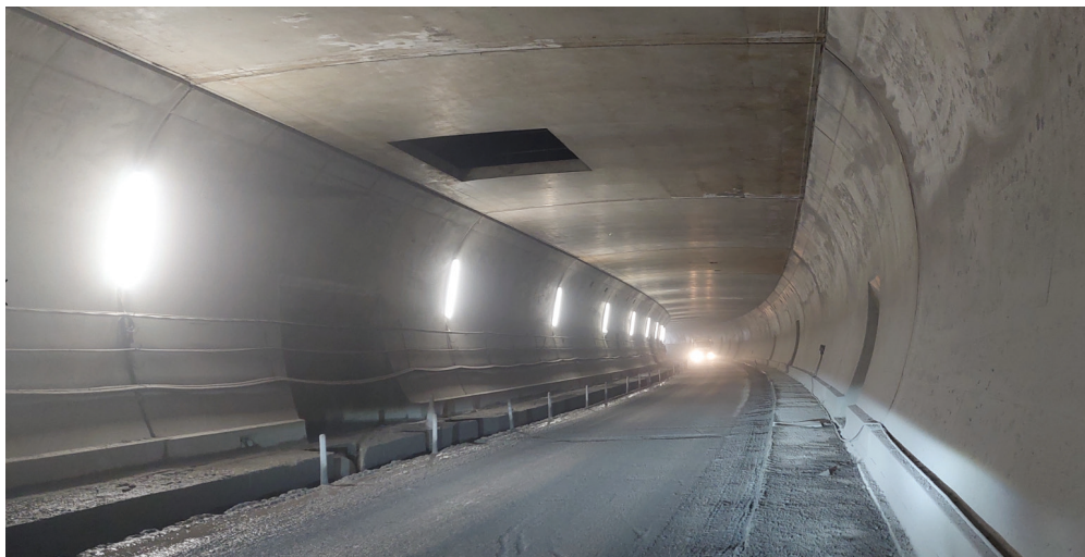
Slika 6. Izvedena notranja obloga in vmesna stropna plošča.
