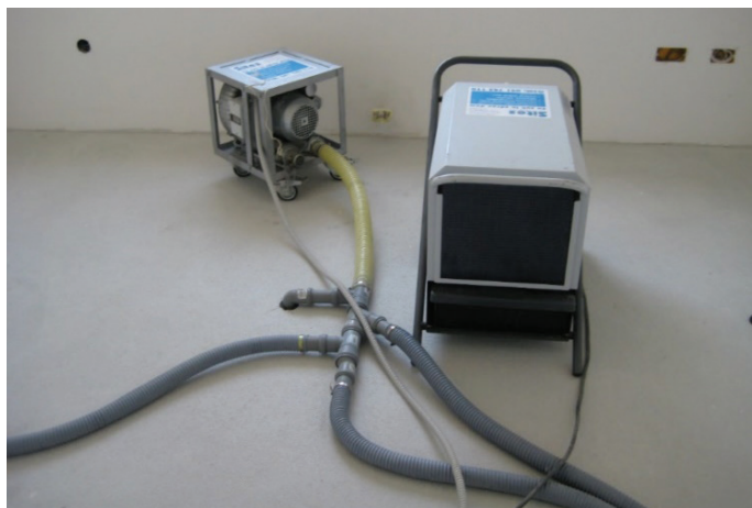
Slika 12. Izsuševanje estriha s turbinsko-kondenzacijsko metodo, avgust 2023.
