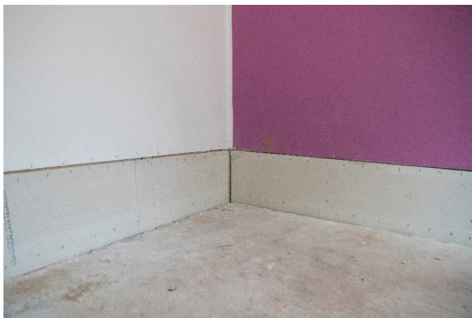
Slika 11. Nameščene stenske obloge, september 2023.
