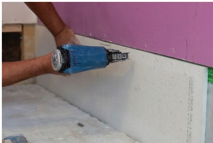
Slika 10. Pritrjevanje stenske obloge, september 2023.
