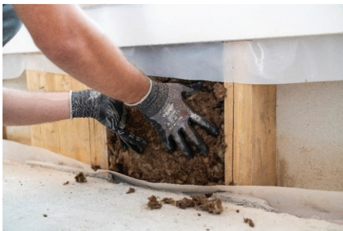
Slika 7. Vstavljanje izolacije, september 2023.
