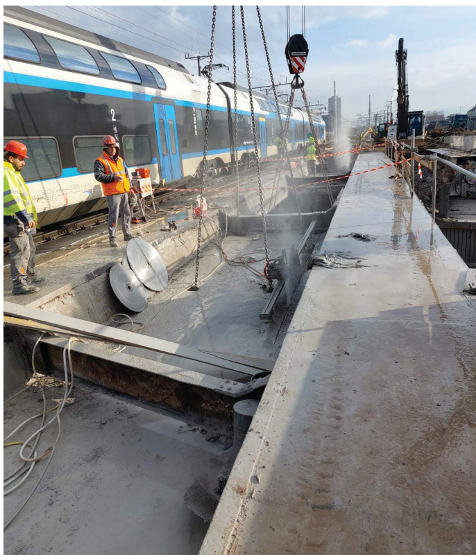
Slika 5. Rezanje prednapete AB-plošče s krožno žago.
