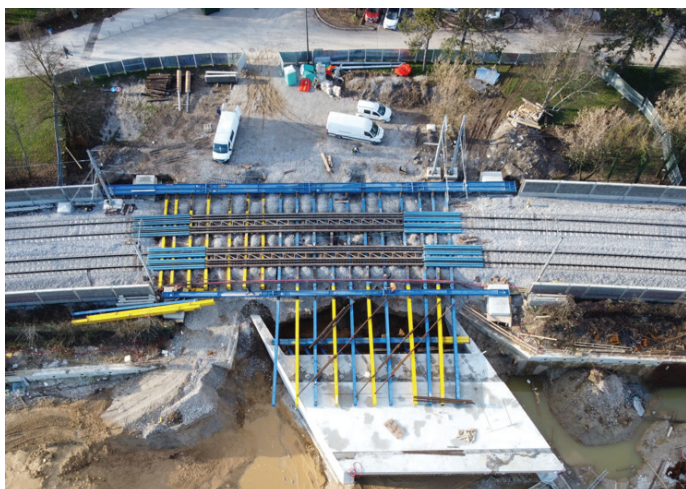
Slika 12. Začetek podpiranja (slika levo) in preboj ter sklepna faza podpiranja (slika desno).
