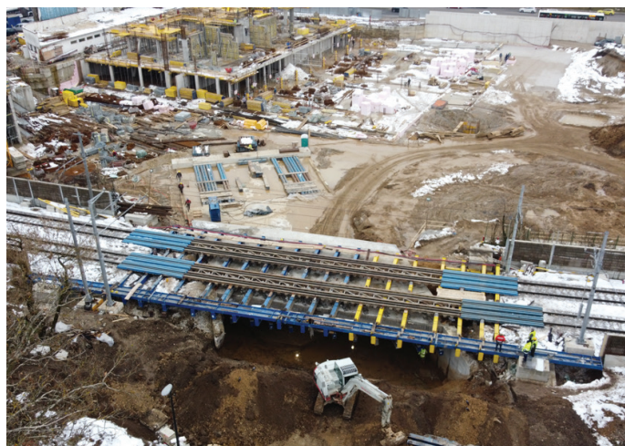
Slika 12. Začetek podpiranja (slika levo) in preboj ter sklepna faza podpiranja (slika desno).
