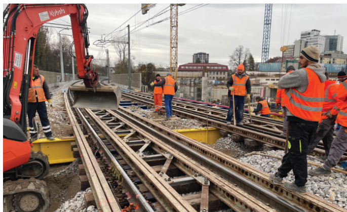
Slika 8. Vgradnja provzorijev in uvlačenje nosilcev pod tire med prometom (slika levo) ter delavnica (slika desno).
