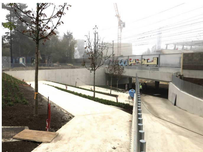
Slika 13. Gradnja izhoda iz podhoda.
