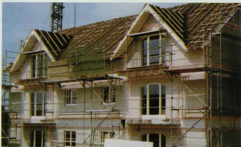
Slika 8: Izdelava fasade, priprave na prekrivanje
