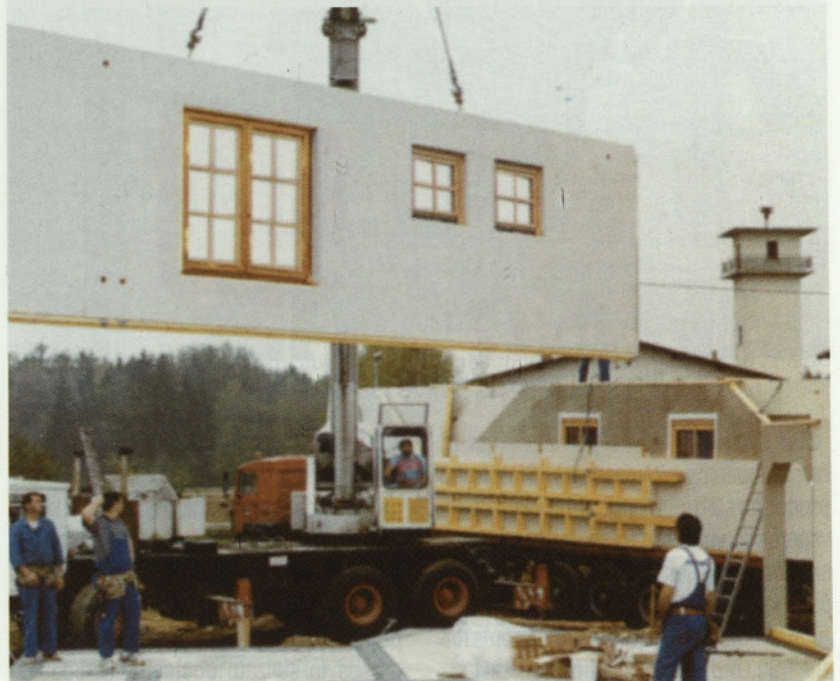
Slika 6: Montaža elementov na objektu
