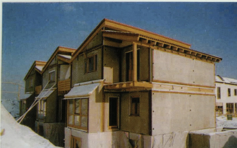
Slika 7: Sestavljeni objekt (vrstna hiša) brez fasade
